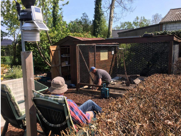
Volière in aanbouw
