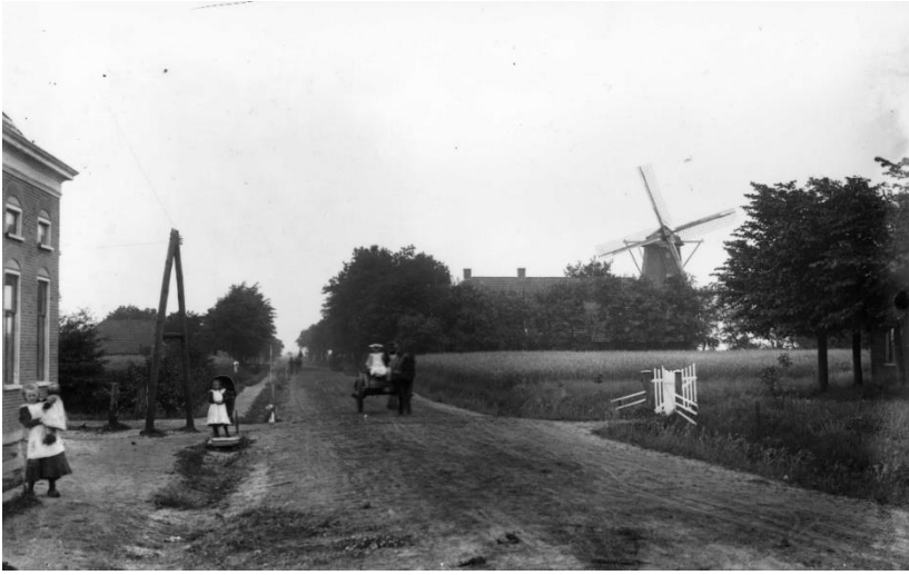
Foto van de molen van Andreas Schoo omstreeks 1900 aan de onverharde weg van Musselkanaal naar Mussel, nu de huidige Kruisstraat. (Collectie Streekhistorisch centrum Stadskanaal)
